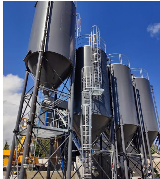
Abbildung 3 Zement-, Flugasche-, Schlacken- und Mikrosilika-Silos in Betonwerken.
