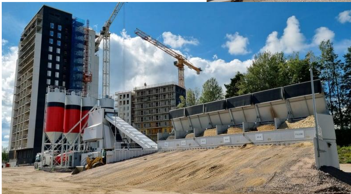
Abbildung 4 Moderne Betonwerke haben sechs Zuschlagstoffbehälter.
