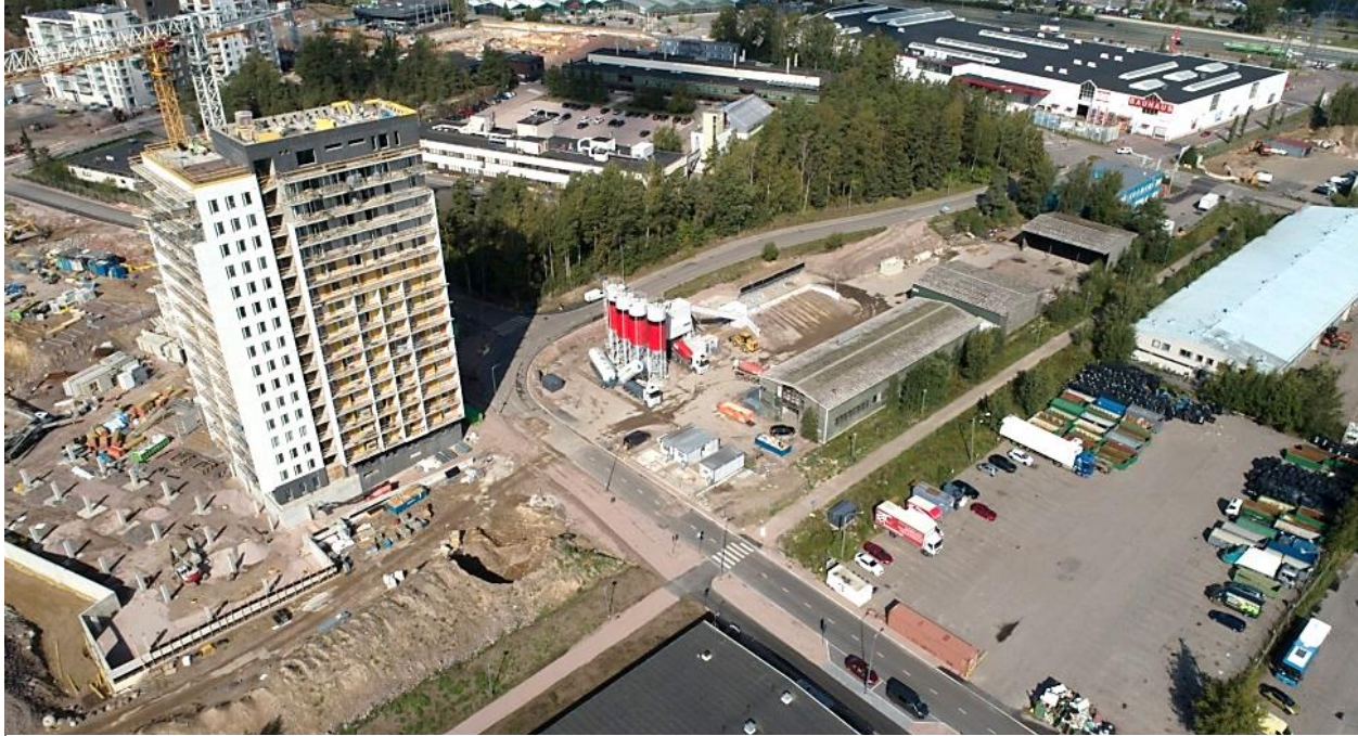
Abbildung 1 Mobile Betonmischanlage im urbanen Umfeld
